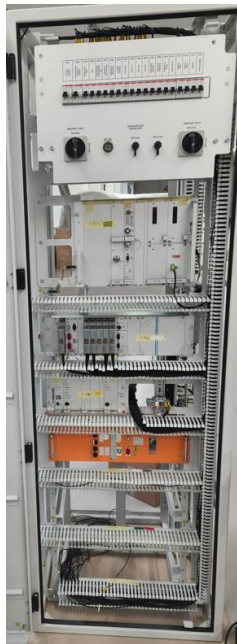
Rozvaděč s částmi ETCS
